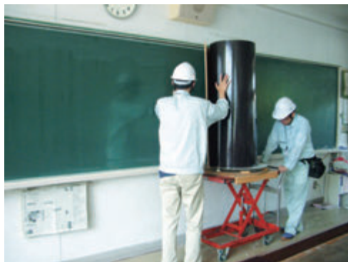
ピタマグロール貼替工法
