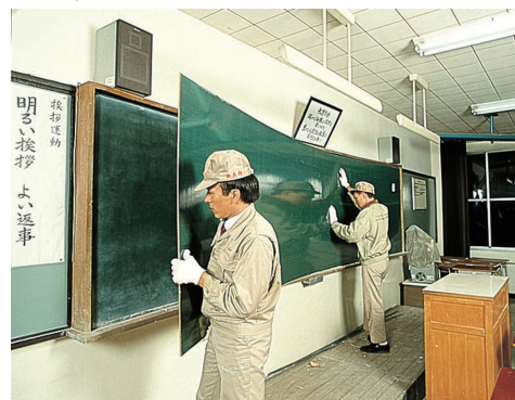
L2 貼替工法
